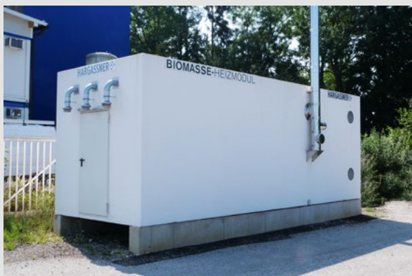
Modulo di riscaldamento a un piano 120 kW pellet, immobile commerciale
