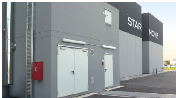
Modulo di riscaldamento a due piani 200 kW cippato, settore commerciale
