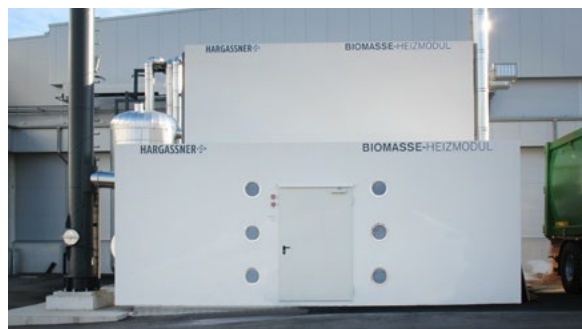
Modulo per il riscaldamento a più piani 660 kW cippato, settore industriale
