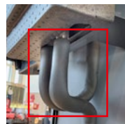
Set di tubatura per accumulo a stratificazione SP con modulo sanitario a piastre FWS
